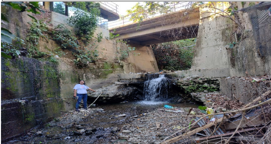
FIGURA N°03: VISTA PANORÁMICA DEL RÍO SHIMIATO, DONDE SE OBSERVA LA BASE DEL PUENTE EROSIONADA EN INMINENTE PELIGRO PARA LA POBLACIÓN USUARIA.
