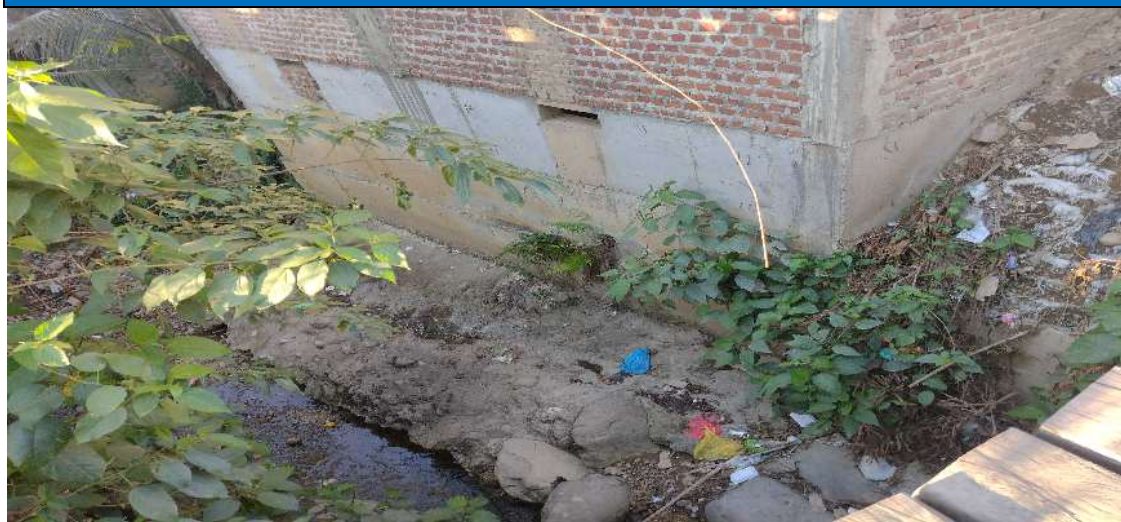
FIGURA N°01: VISTA DE AFECTACIÓN DE LA BASE DE LA VIVIENDA POR CRECIDA DEL RÍO SHIMIATO
